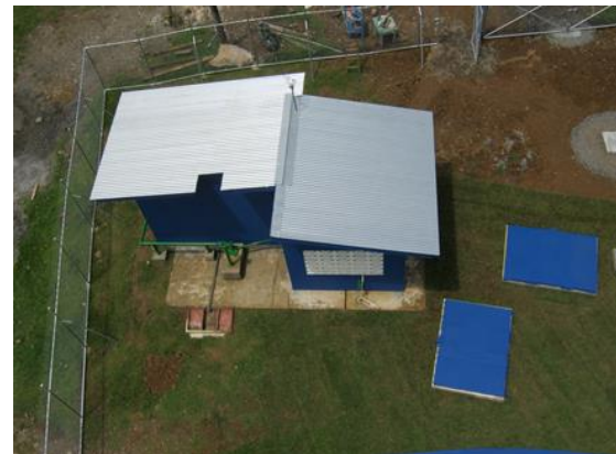
Fotografía 4: Vista de la caseta de bombeo desde tanque elevado. Acueducto Palmitas II. 10 de octubre 2014
