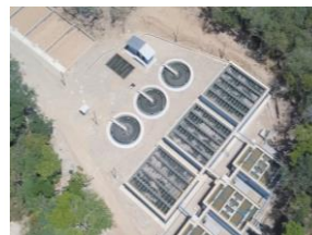
Panorámica de Filtro Percoladores y Sedimentadores PTAR
